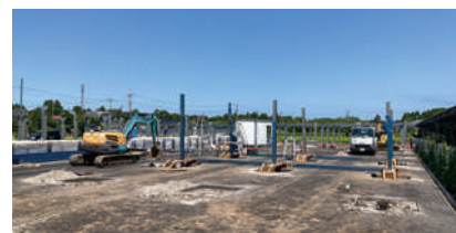
② 支柱建て方、コンクリート打設
