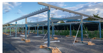
③ カーポート躯体組立
