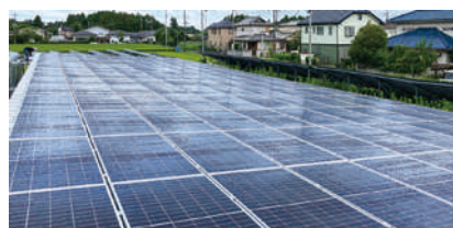
⑥ モジュール設置
