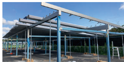
④ 折板屋根取付
