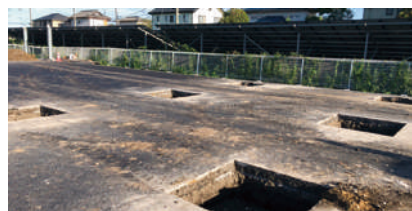
① 基礎掘削作業
